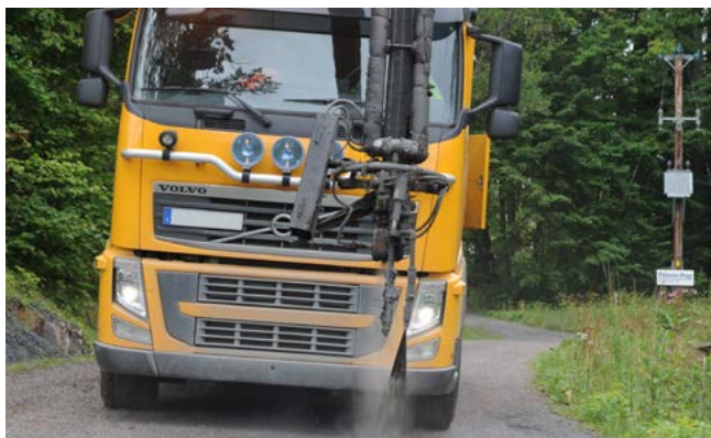
"Snabelbilen" som lagar sprickor och hål i asfalten är ett exempel på arbetsfordon.
